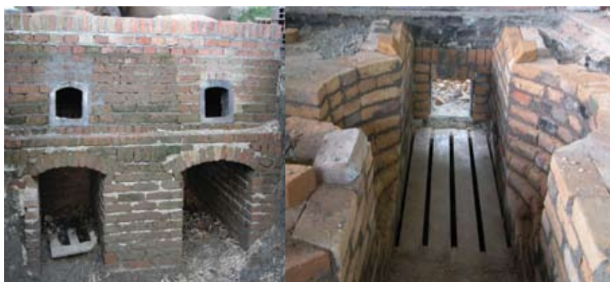
FIGURA 29. Puerta de alimentación en hornilla con cámara doble, parrilla vista interior y diagrama.
